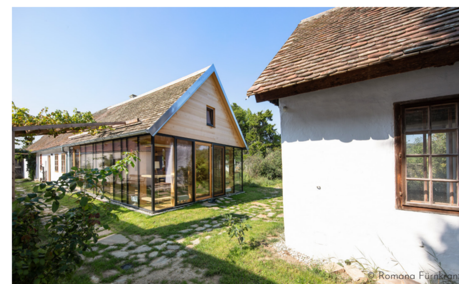
Weiters Beispiel wo ein ehemaliger, schmaler Hof behutsam zu einem zeitgemäßen Wohnhaus umgeformt wurde
