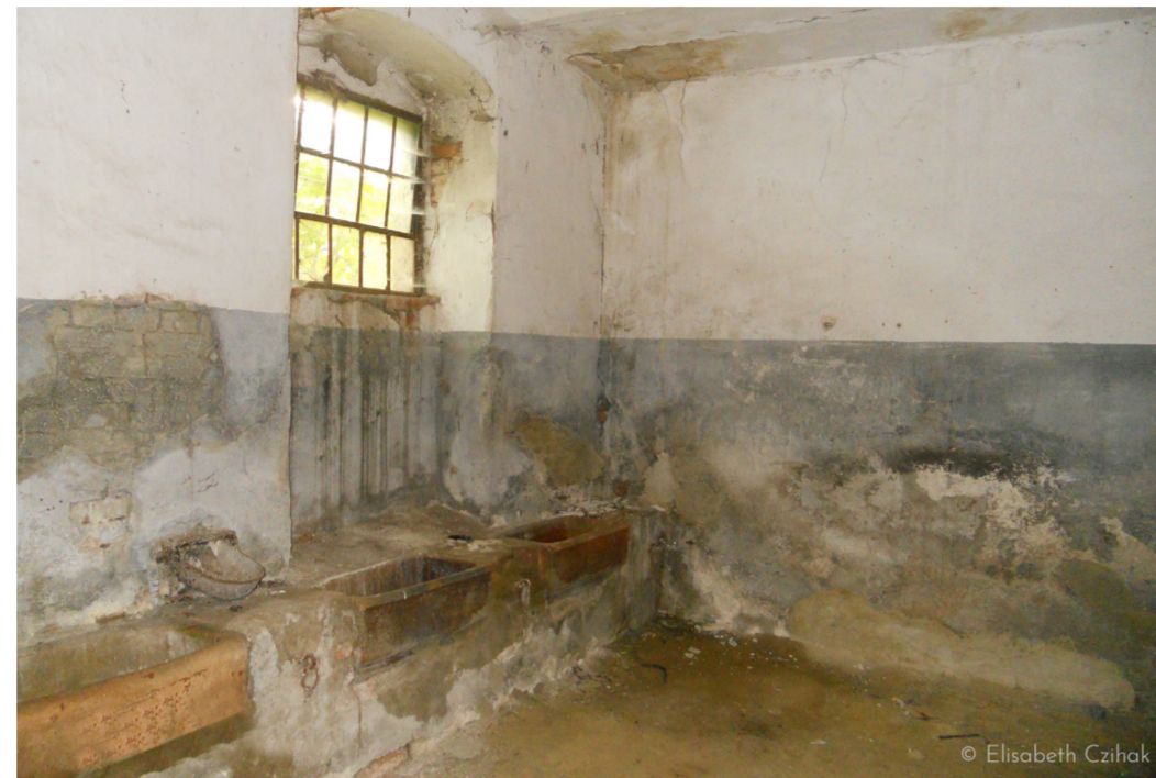
Dieser Stall sollte zu einem Wohnraum umgebaut werden
