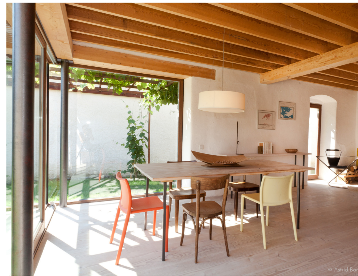
Das 1850 erbaute Lehmhaus nach behutsamer Transformation: Höhere und hellere Räume durch das Absenken des Bodens oder dem Abbruch der Parapete
