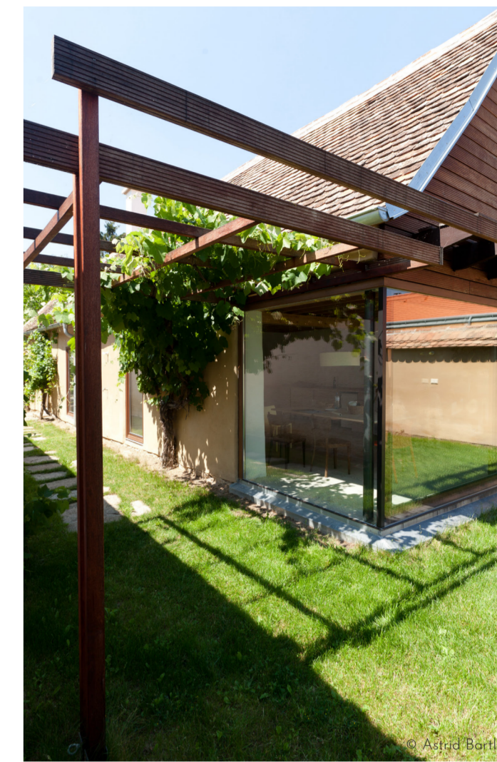
Dicke Lehmwände bieten Schutz vor sommerlicher Überhitzung
