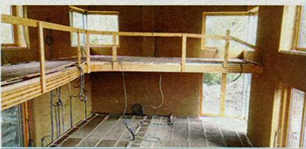
**Verputzen** Direkt auf die Ballen werden 4 cm Lehm aufgetragen, Schicht für Schicht.
