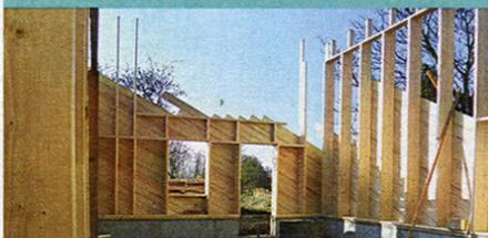
**Bauen** Auf einem Streifenfundament steht ein Holzständerwerk mit diagonaler Verschalung.
